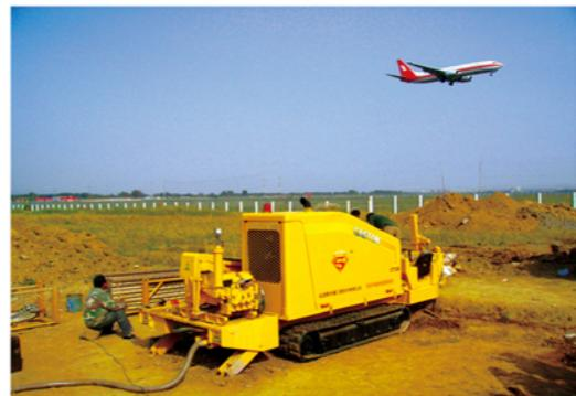
北京首都机场为空客 A380修建输油管道，采用我厂生产的凯斯通牌钻机及现代非开挖钻具，实现定向穿越。
