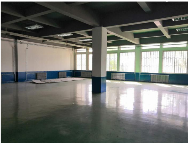
生产车间现状
